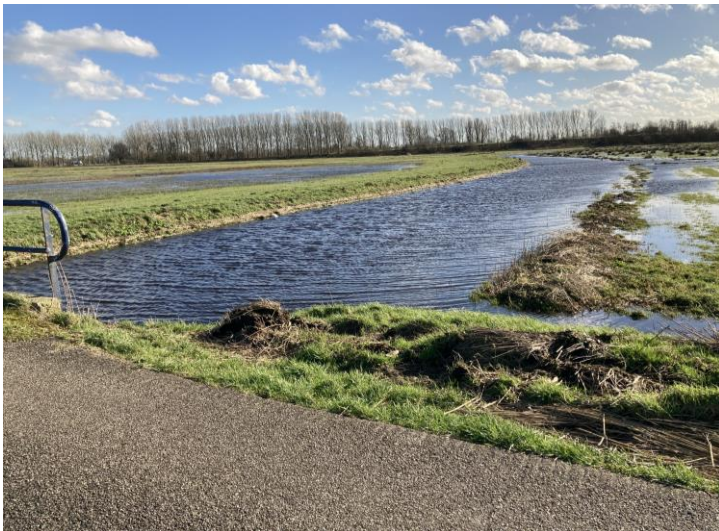
Turfweg hoogwater februari 2022
